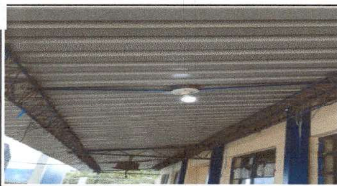
Foto 5: Cambio de focos ahorradores en corredor
