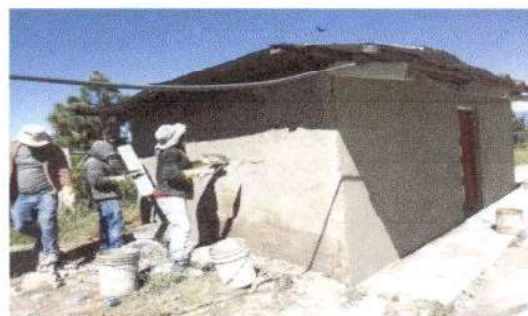
Foto 10: Reparación de repello y cernido de paredes en cocina
