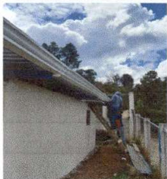
Foto 7: Sustrucción de canal de pvc y bajadas de agua pluvial
