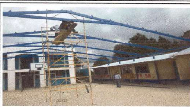
Foto 2: Renovación de estructura de madera por metal
