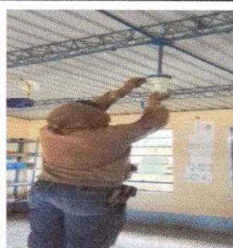
Foto 8: Sustrucción de focos ahorradores en modulo 1 y corredor
