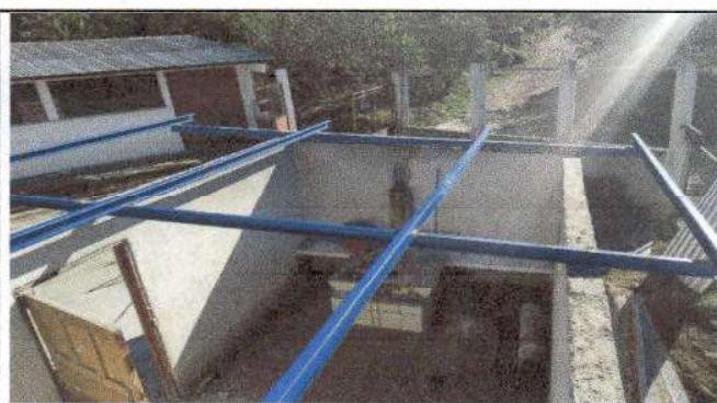
Foto 4: Colocacion de estructura de metal (cocina)
