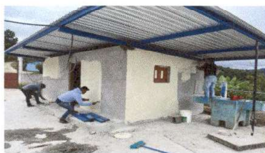
Foto 12: Aplicación de pintura en muros exteriores en cocina
