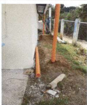
Foto 7: Sustrucción de canal de pvc y bajadas de agua pluvial
