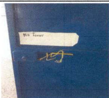
Foto 9: Sustrucción de chapa puerta modulo 2
