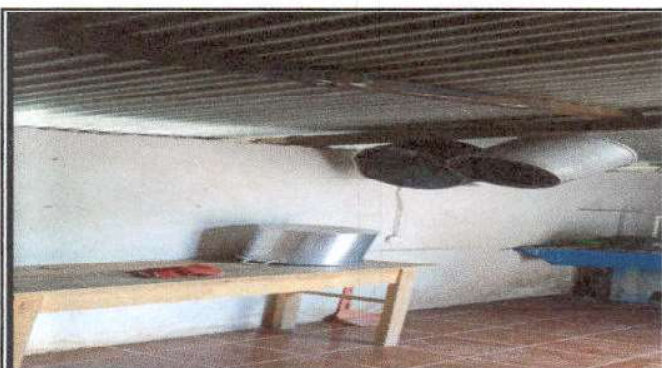
Foto 3: Remplazo de lámina por lámina troquelada aluzinc calibre 26 (cocina)
